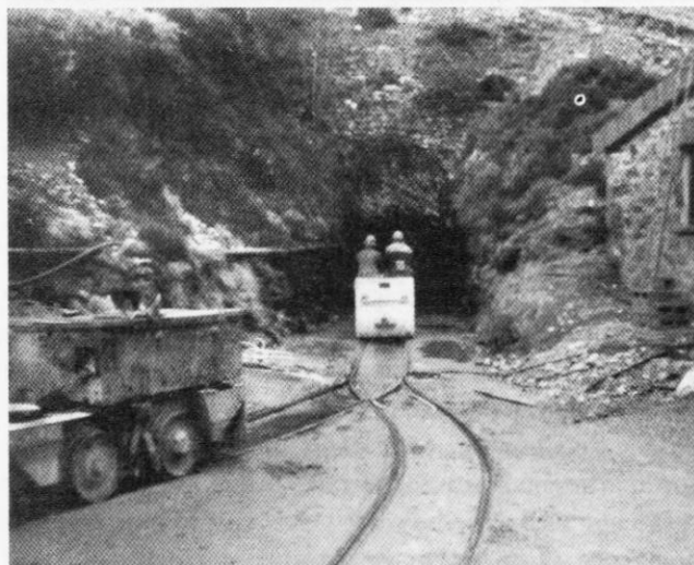
Gwynfynydd mine adit
